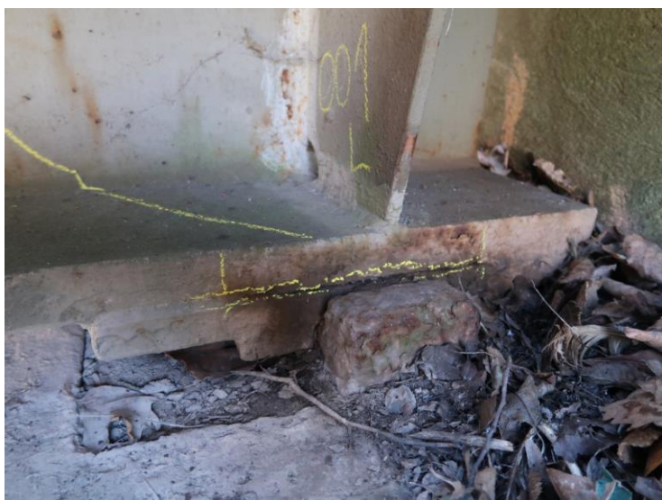
Foto č. 2 Konstrukce K 01 – ložisko O 01 vlevo – trhлина mezi levým hlavním nosníkem a deskou ložiska
