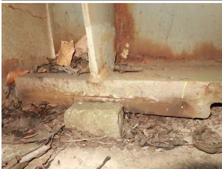
Foto č. 3 Konstrukce K 01 – ložisko O 02 vpravo – trhлина mezi pravým hlavním nosníkem a deskou ložiska
