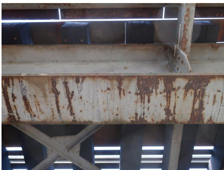
Foto č. 1 Konstrukce K 01 – pravý hlavní nosník podhled – podřevá PKO - koroze
